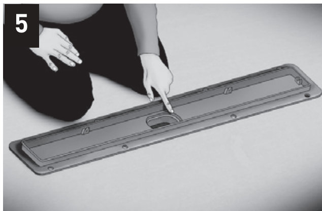
5 После установки прокладки, залить выравнивающий слой для пола
